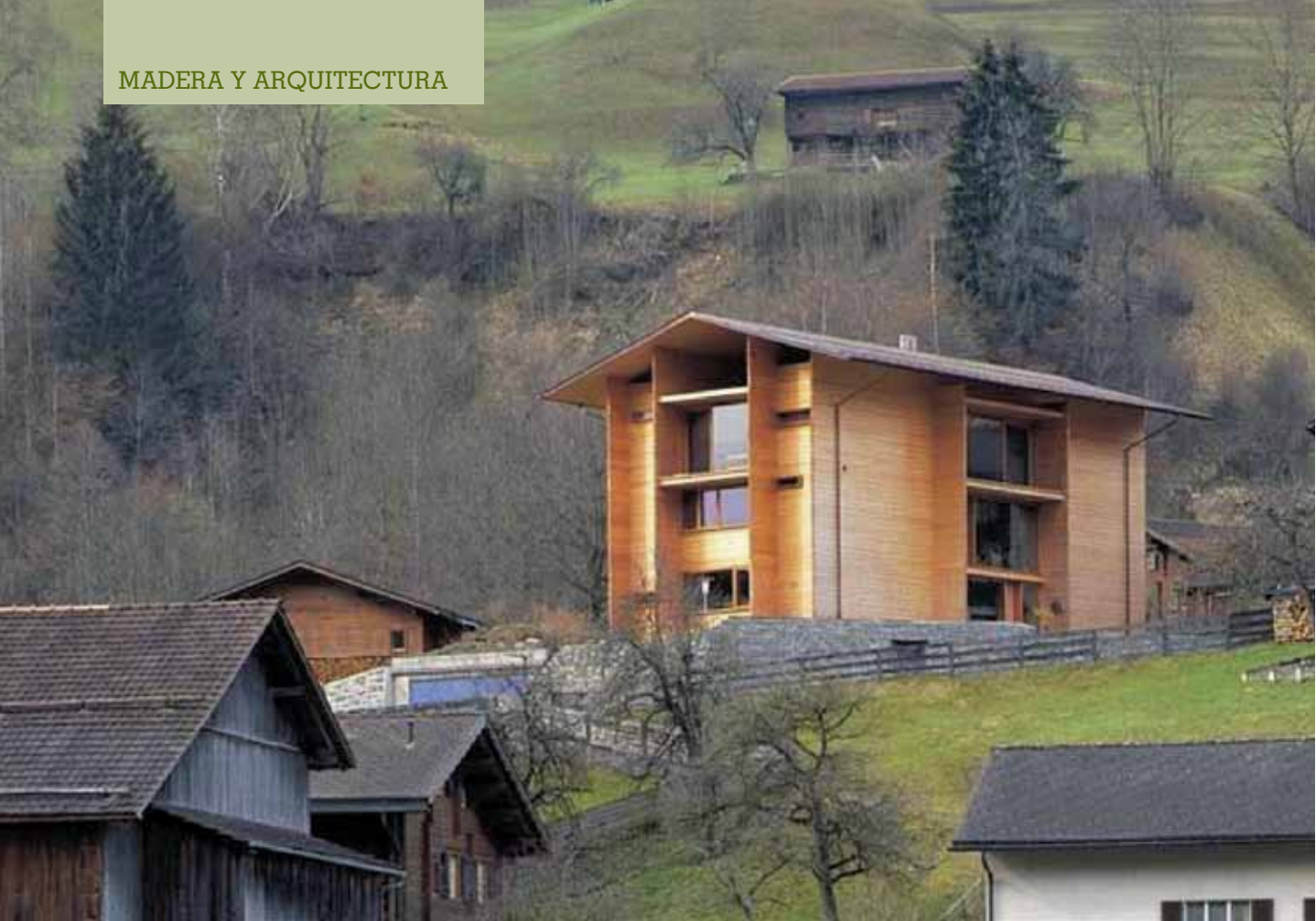
Casa Luzi (Jena, Suiza). Construida de madera maciza, aplicando las nuevas reglas constructivas propuestas por Zumthor.
