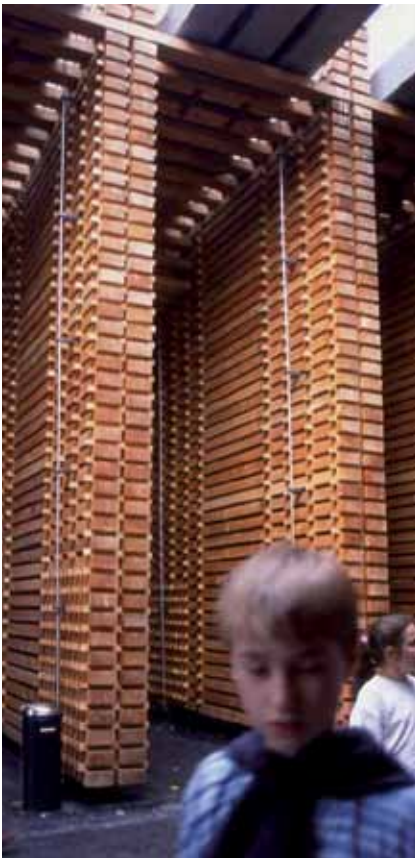
Pabellón Suizo Expo 2000 (Hannover, Alemania).
