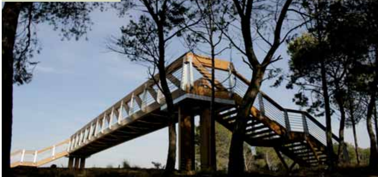
Pasarela de madera tratada en Viana, Navarra (MADERGIA)
