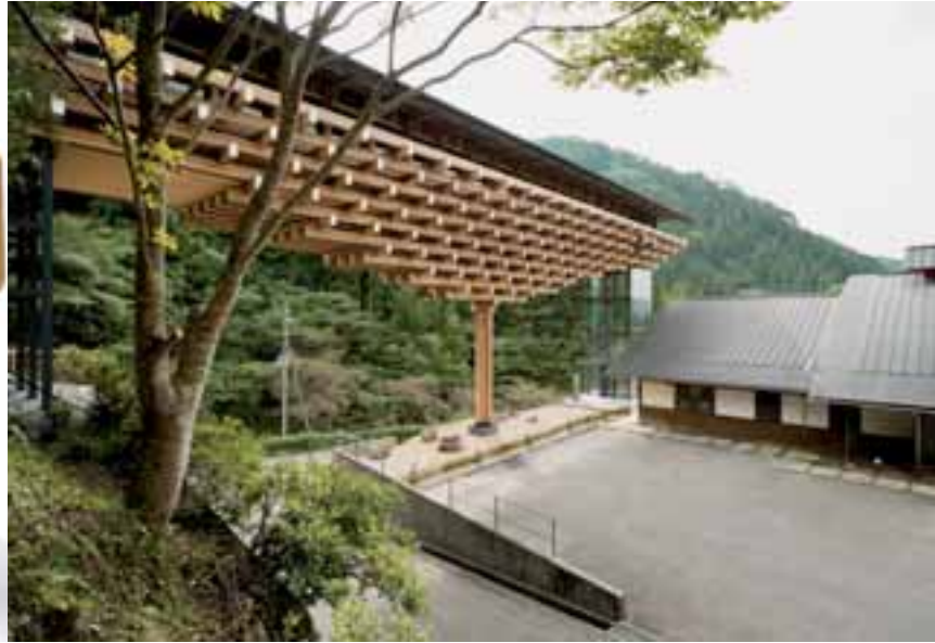
Las técnicas de los 4 aleros tradicionales (dougong, izquierda) se aplican, en otra escala, a la construcción de un edificio puente (Yusuhara, derecha)
