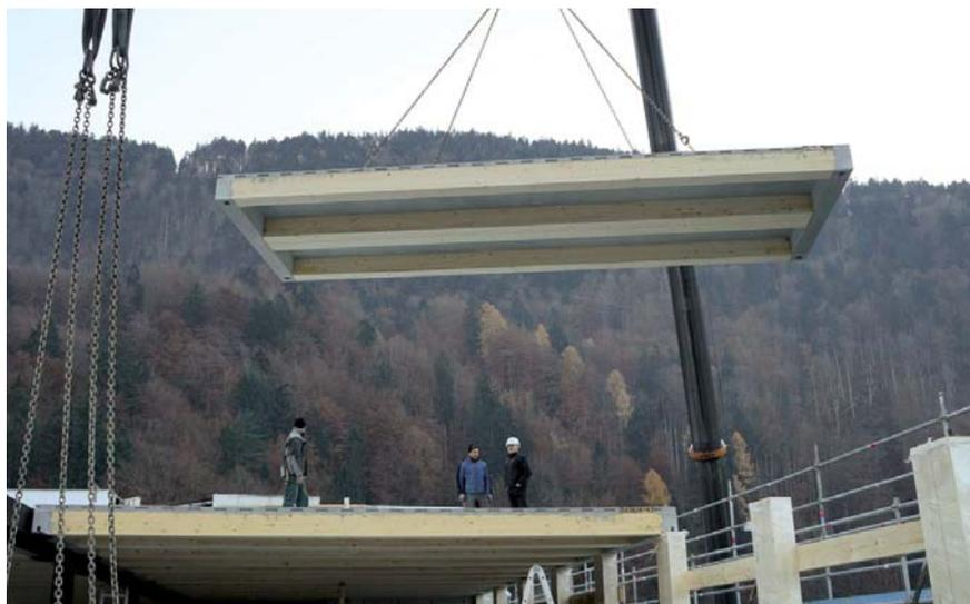
Imagen del proceso de construcción del edificio de oficinas IZM. Colocación de los paneles de forjado
