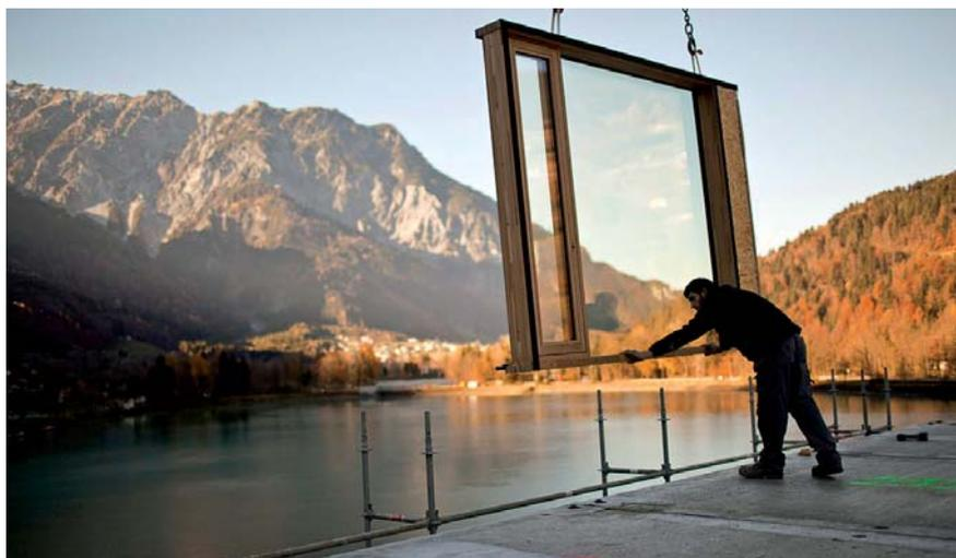
Imagen del proceso de construcción del edificio de oficinas IZM. Colocación de fachada
