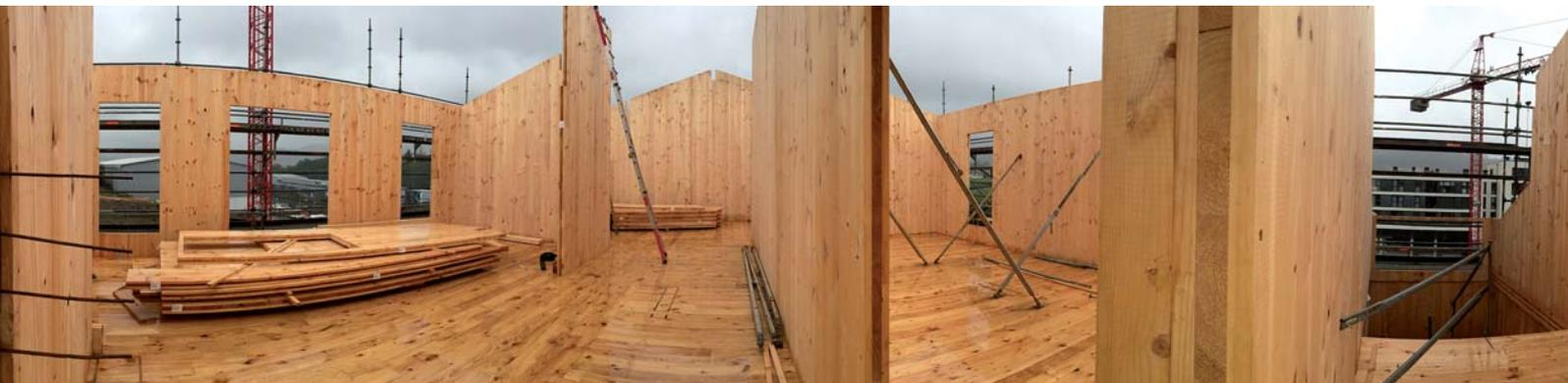
Los paneles portantes de CLT son de singular esbeltez, apenas 8 cm de espesor
