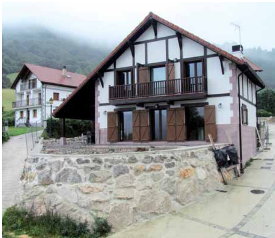
Vivienda Unifamiliar Passivhaus en Orbaizeta
