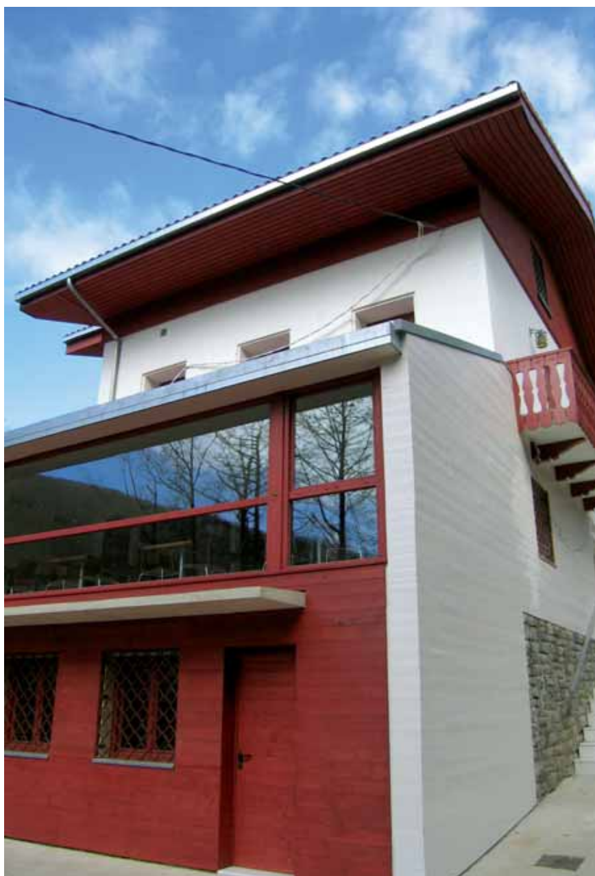
Rehabilitación de edificio para hostel en Eugui, Navarra
