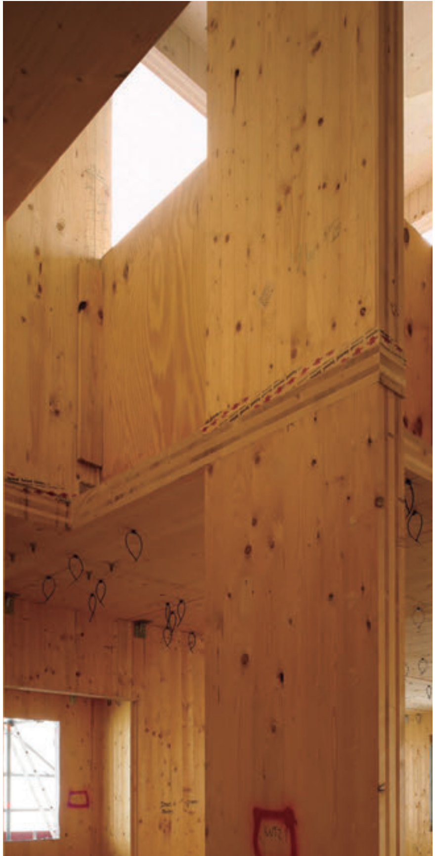
Las viviendas de Murray Grove construidas en su totalidad con paneles de CLT. (Fotografías de Will Pryce).
