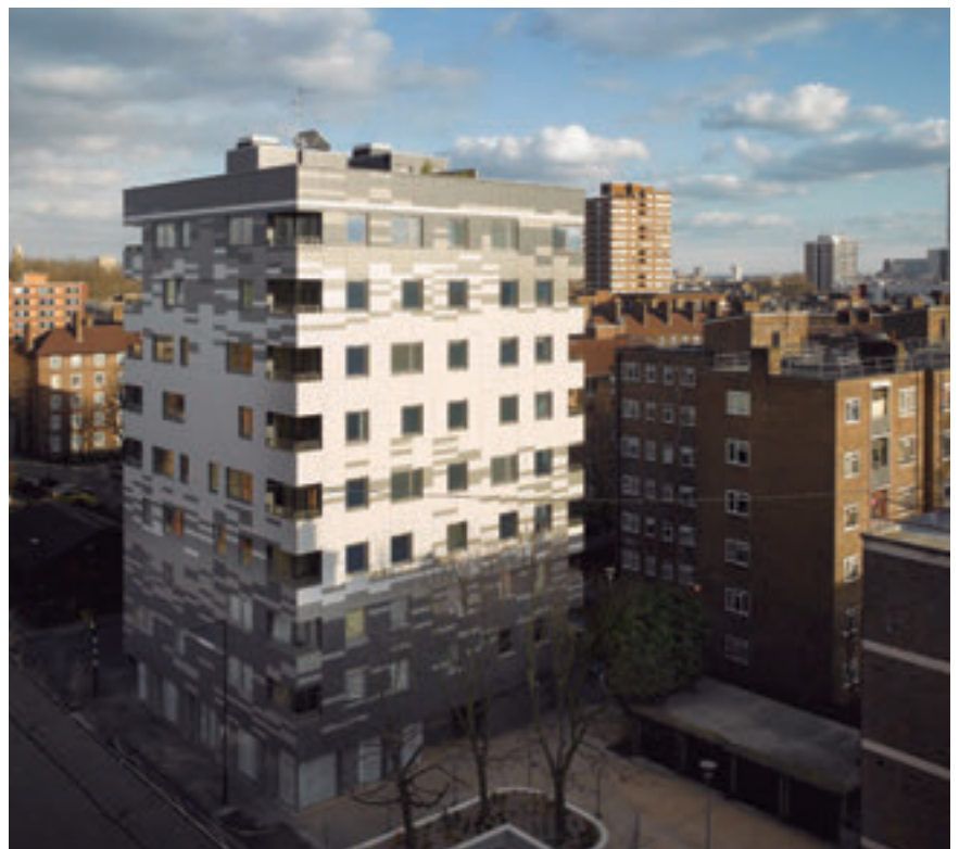
Edificio pionero y referencia para la construcción con madera. (Fotografías de Will Pryce).
