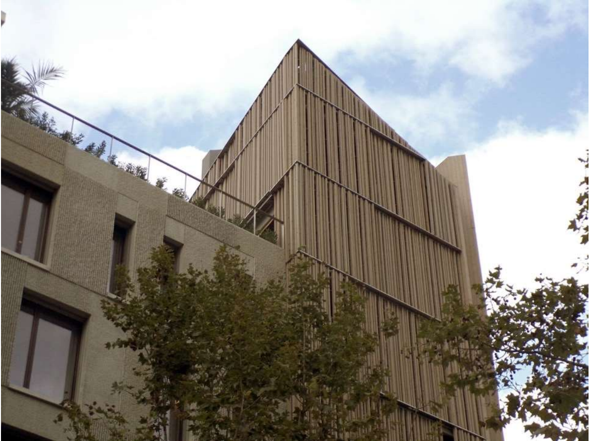
(Proyecto Paseo de Mallorca 15 con fachada de madera de Grupo GUBIA. Fotos Gubia©)
