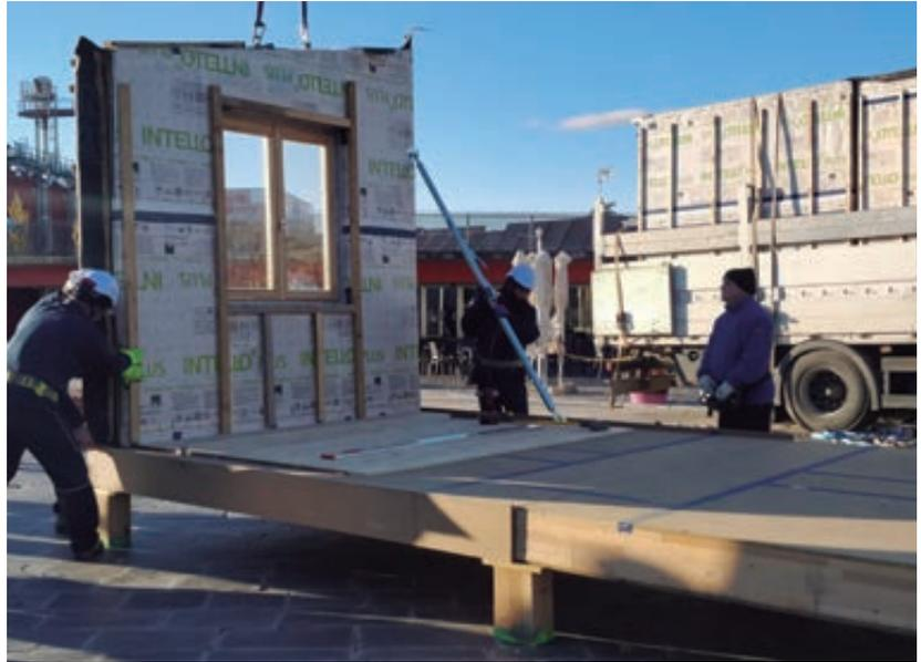
Entramad es flexible y adaptable a los diferentes requerimientos y necesidades constructivas de cada obra y construcción, y tiene como premisa la protección y durabilidad de los materiales utilizados. Imágenes: jornadas de formación sobre construcción eficiente e industrializada con madera desarrolladas por Cesefor dentro del programa MADERAULA.
