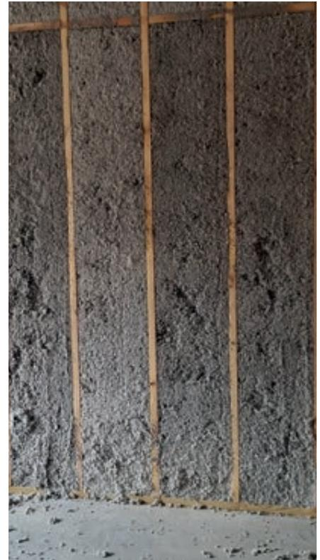
El insuflado de celulosa es un sistema muy eficiente, rápido y accesible. Responde al reto de construir de una forma eficiente y utilizando productos naturales, para reducir los consumos energéticos al mínimo.
