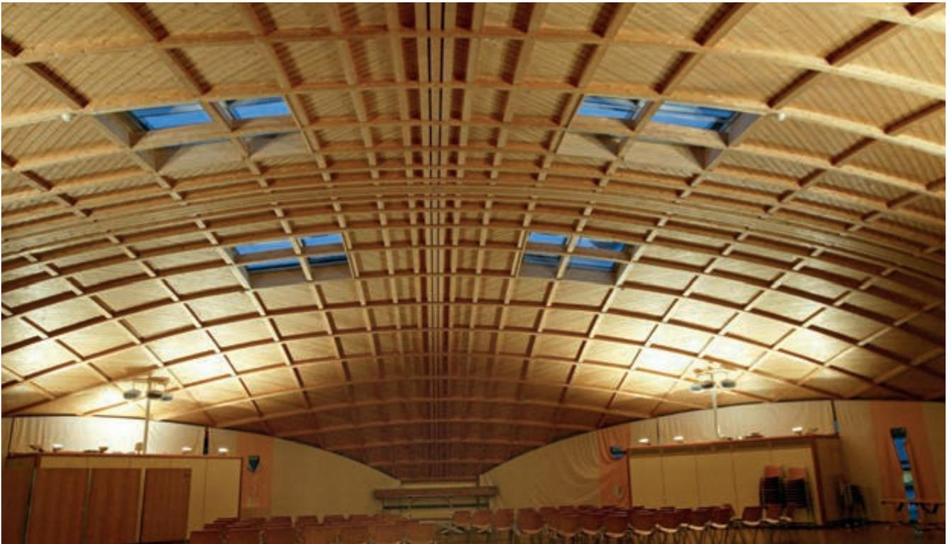
La cubrición del Polydome fue una de sus primeras experiencias con tablas clavadas para construir una lámina estructural.
