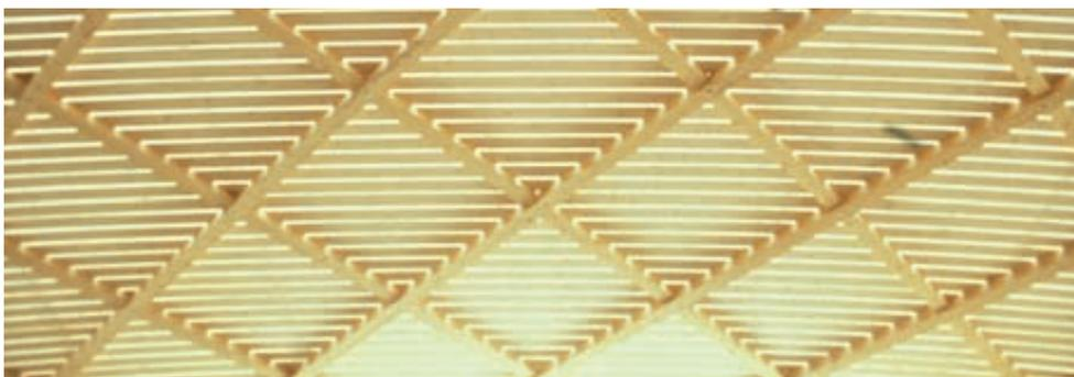
Detalles de algunas de sus estructuras de láminas construidas simplemente con tablas clavadas.
