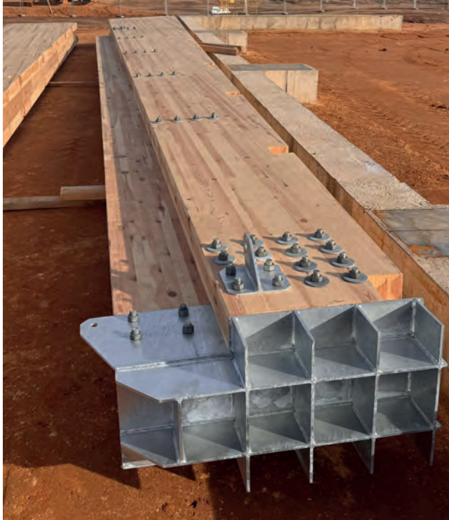
Imagen izqda.: Pilares de madera laminada encolada de pino silvestre certificados FSC. Imagen dcha.: Paneles de entramado de fachada terminados desarrollados en el proyecto Construyendo Maderaula.
