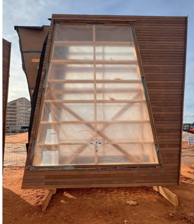
Imagen izqda.: Pilares de madera laminada encolada de pino silvestre certificados FSC. Imagen dcha.: Paneles de entramado de fachada terminados desarrollados en el proyecto Construyendo Maderaula.
